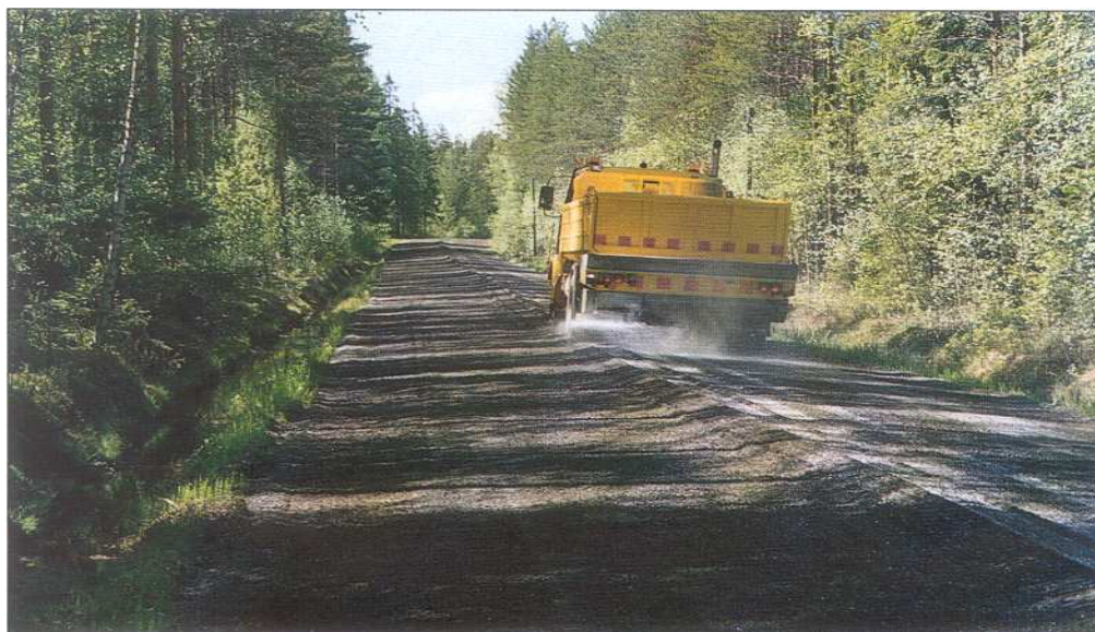
Pilt 1. Sool laotatakse kruusavalli peale ühe laotuskorraga.
