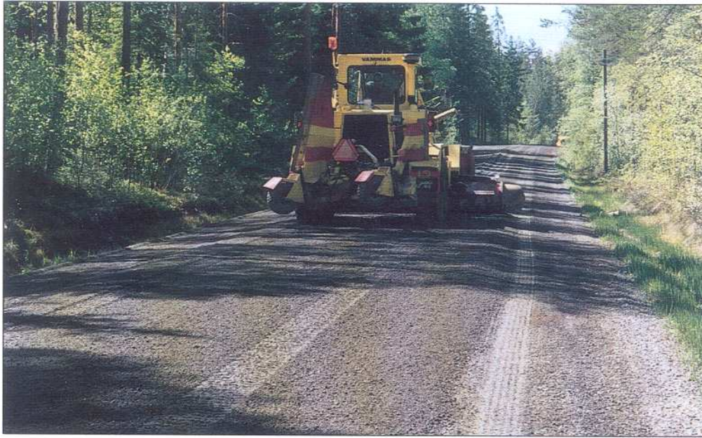
Pilt 2. Kulumiskiht segatakse ja viimistletakse teehöövliga.
