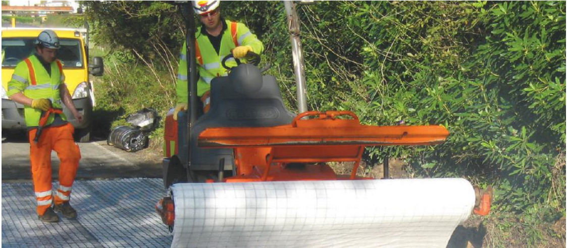
Joonis 4. Paigaldusmasina üks lahendusvariantidest (esmatähtis on et seadeldis eelpingestaks materjali piisavalt, et vältida kortse jms).
