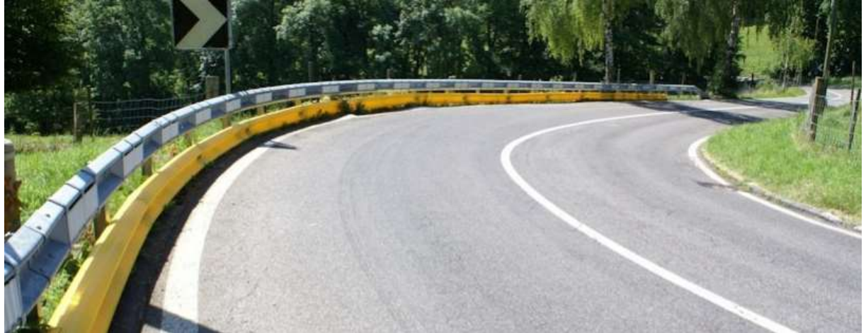
Joonis 12. Mootorratturitele ohutu põrkepiire ( Lindsay Corporation ).
