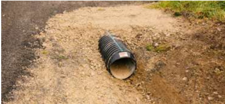
Joonis 30. Kergestipurunev truubiots (HYNDZ).
