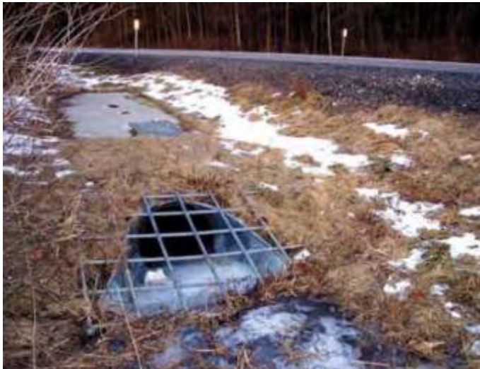
Joonis 31. Võrega kaetud truubiots ( AASHTO ).
