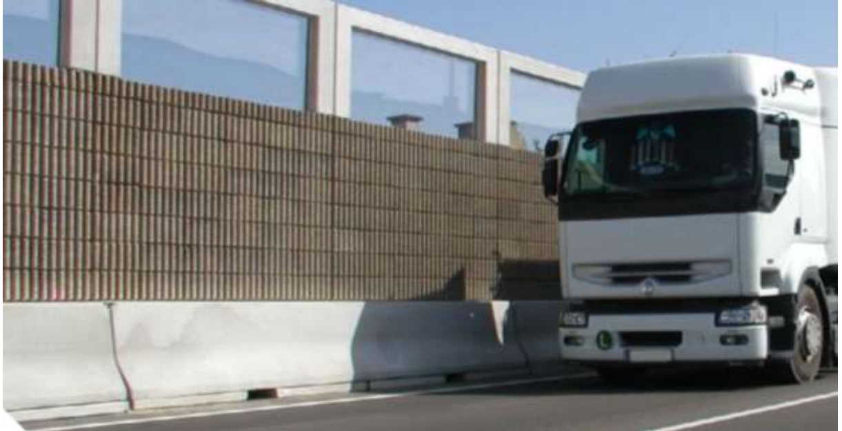
Joonis 16. Integreeritud mürasein ja pörkepiire ( DeltaBloc ).
