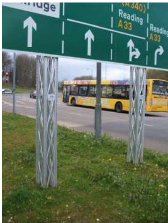
Joonis 15. Passiivselt ohutu liiklusemärgi post ( Transport Research Laboratory ).
