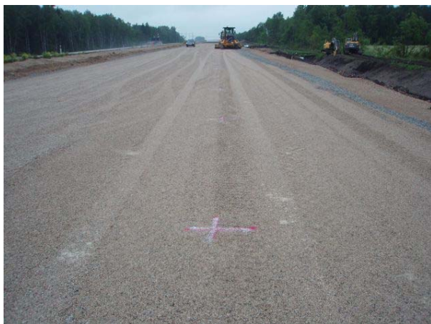
Pilt 1. Teekonstruktsiooni kandevõime mõõtmiskoha tähistus killustikalusel
