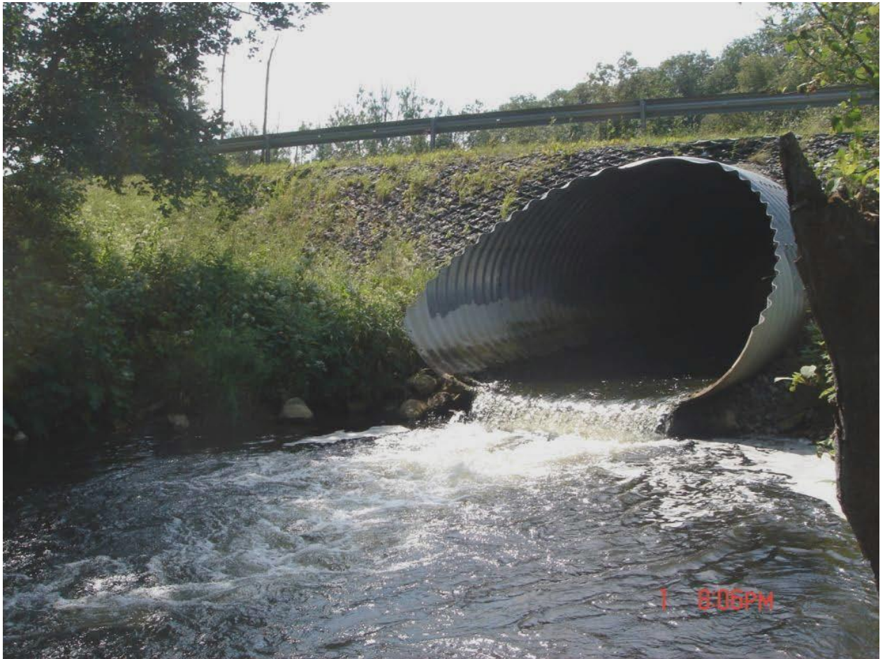
Foto 4. Kaliküla truup Toolse jõel Kunda-Selja teel 2012. aasta juunis (foto: Avo Sulger). Truubist allavoolu tõsteti kärestikuga veetaset ja suurendati vee sügavust truubis tagamaks jõesilmu läbipääsu truubist, vt lisadest 4 foto 20.
