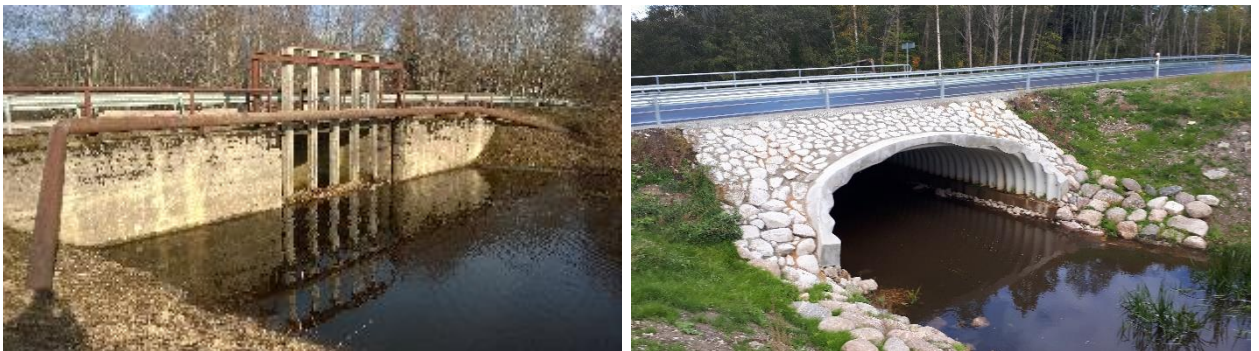
Foto 7. Alliku pais 05.03.2017 ja uus Alliku torusild Väana jõel, Laagri Hüüru teel Vaata ka põhjaruanne pt 5.5.
