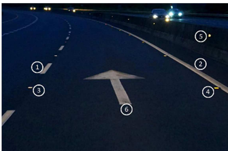
Joonis 5. RetroTek-M™ mõõteseadme poolt mõõdetavad erinevad teekattemärgistused
